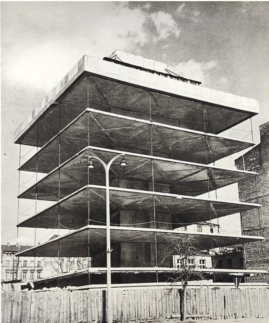
Trzonolinowiec w trakcie budowy w 1965 r., domena publiczna, Wikipedia
