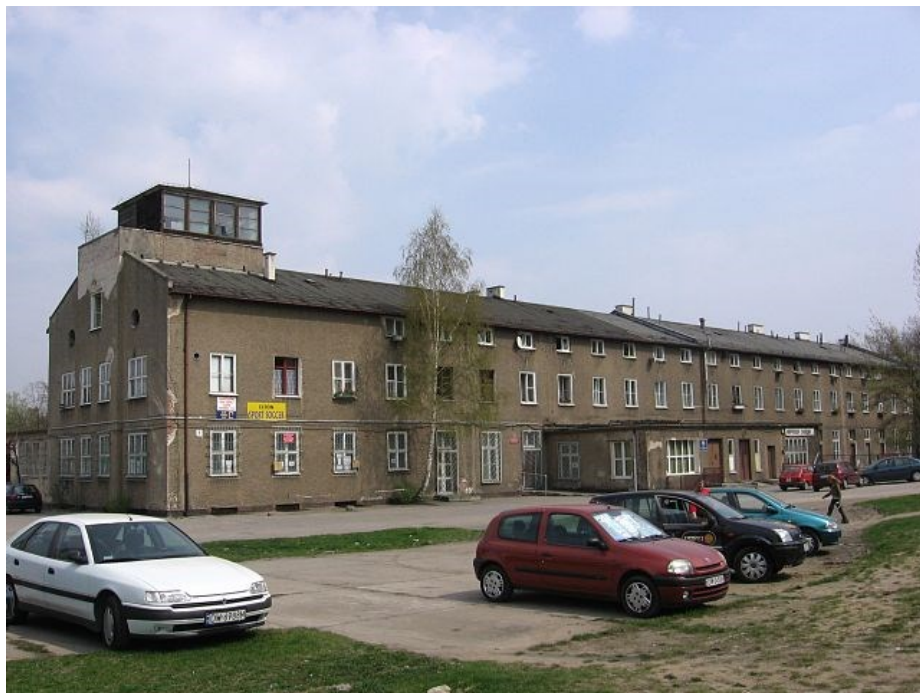
Dawny budynek lotniska na Gądowie (zbudowany w 1936) i jego wieża kontroli lotów, Wikipedia, domena publiczna
